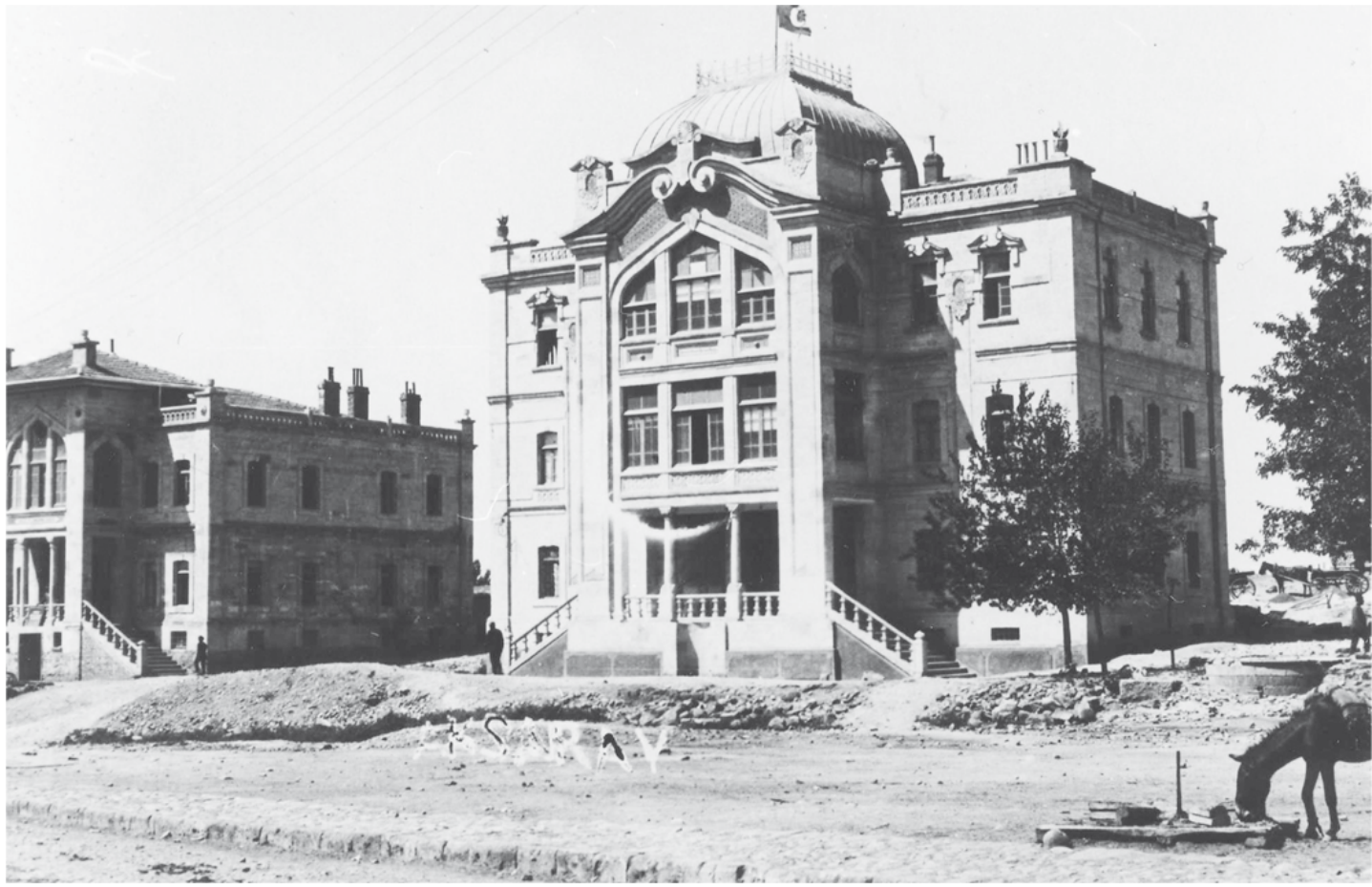
Aksaray, Hükümet Konağı.
