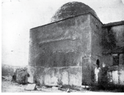
1927 yılında yıkılan Selçuklu eseri Nalınca Baba Türbesi.
