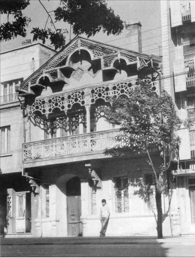
SAMET KURUCU'NUN EVİ Gazi Lisesi'nin karşısında idi. 20. yüzyıl başlarında yapılmıştı. İlk sahibi Augustus'un istasyonda oteli vardı. Bu yapıda 1982 yılında koruma altına alınmasına rağmen daha sonra yıkılmıştır.
