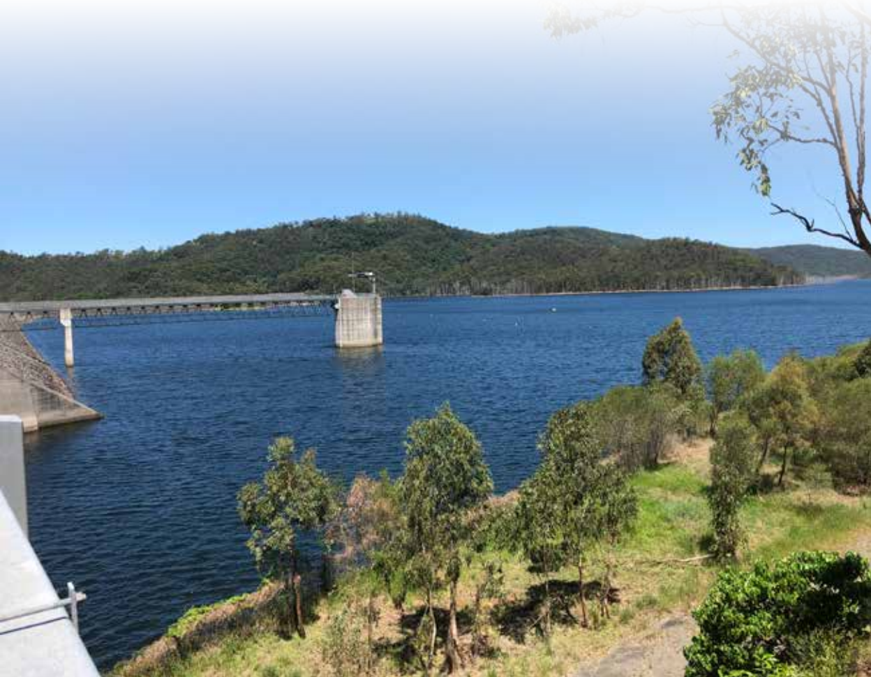
Hinze Barajı dolu savak kulesi
