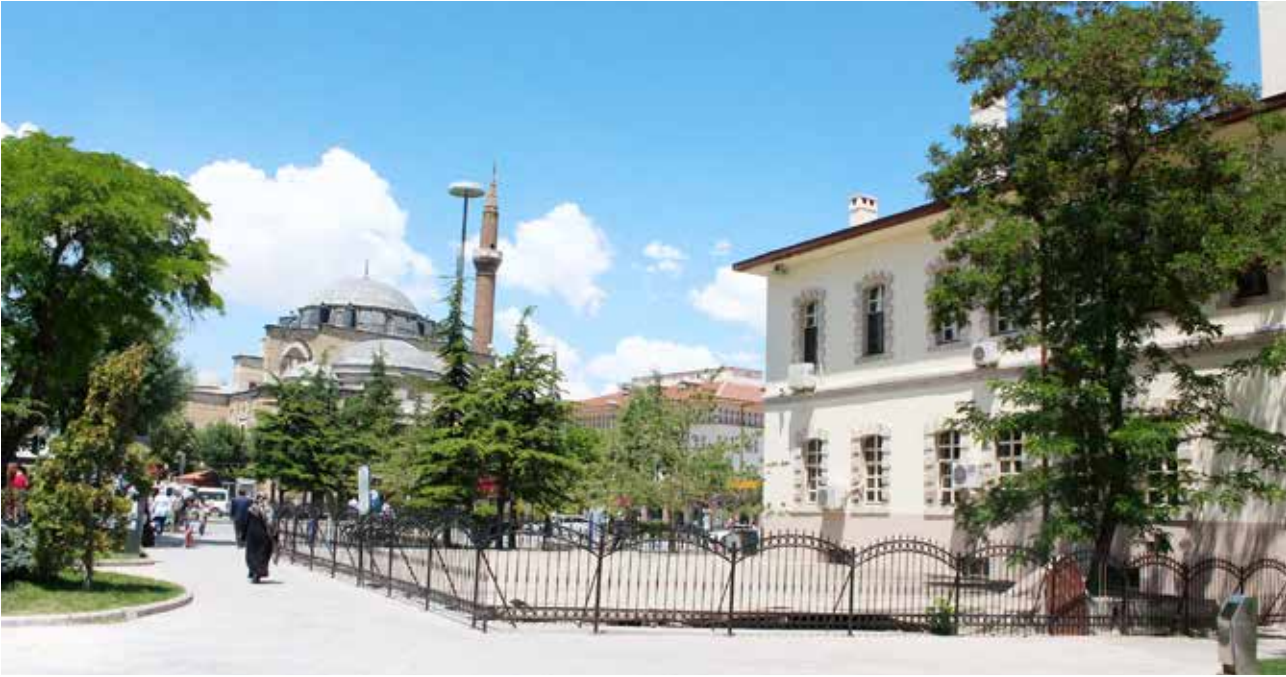
Valilik binası batı tarafı.
