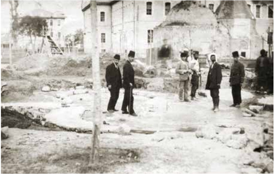
Hükümet binasının batı tarafında Ulvi Sultan Mescidi ve yol çalışması.
