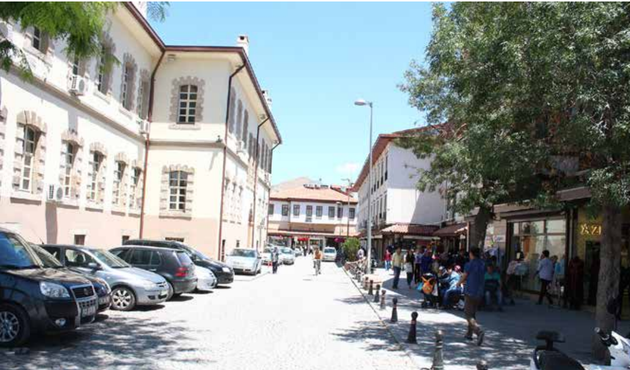
Hükümet binası güney cephesi.
