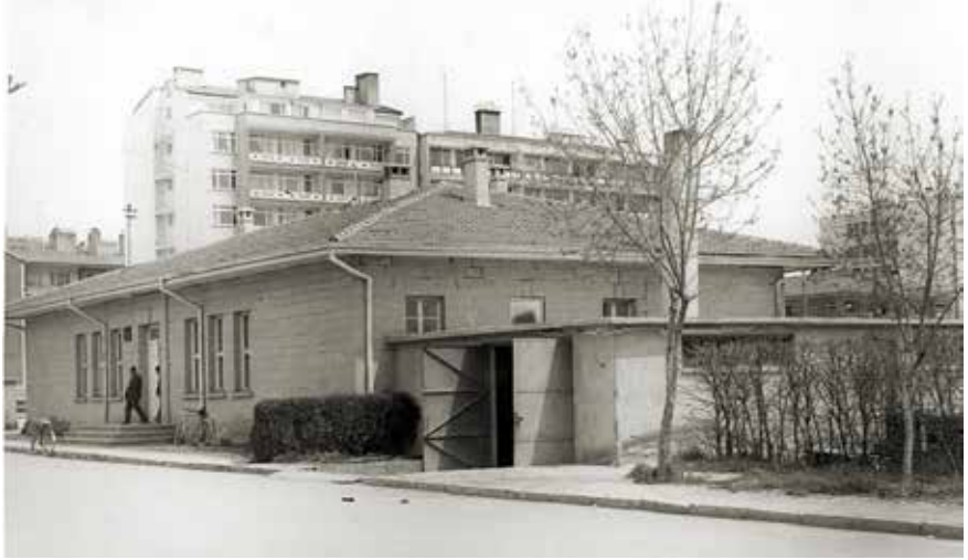
1950 yılında tek katlı olarak inşa edilen Hizmet Binasının genel görünüşü (A. Bülent Melik Arşivinden)
