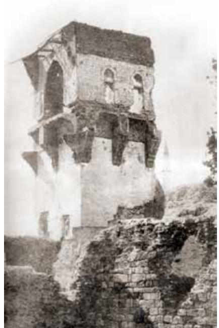
II. Kılıçaslan Köşkü ve Konya iç sur duvarları.
